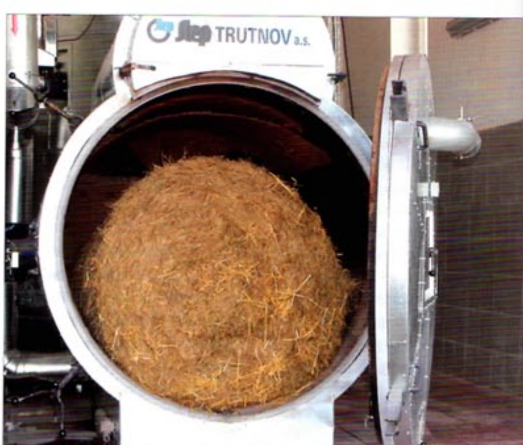
Kotel na spalování slámy s ručním přikládáním o výkonu 190 kW slouží například na farmě Kepy na Šumavě Foto archiv/CZ Biom
